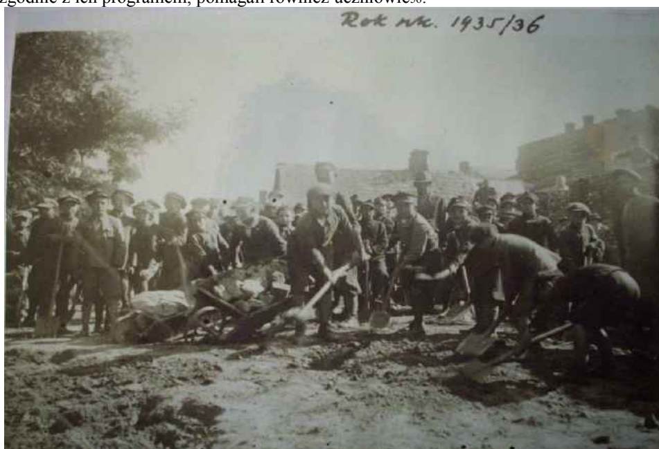
„Prace dziatwy szkolnej przy równaniu boiska i budującej się szkole”, źródło: Kronika Szkoły Nr 2, s. 7
